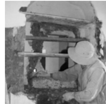
Liberación de muros de ladrillo que una vez retirado se identifica una alacena. Convento de Santa Teresa – Sucre – Chuquisaca, Bolivia
