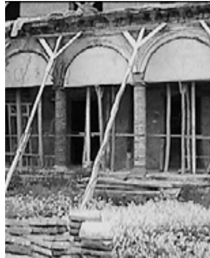
Apuntalamientos. Palacete de la Florida - Chuquisaca, Bolivia
