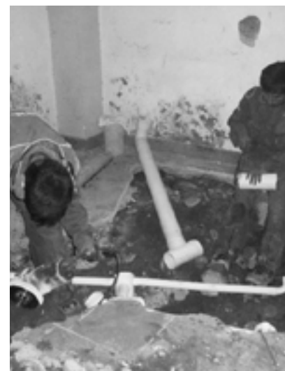
Incorporación de instalaciones sanitarias. Convento de Santa Teresa – Sucre – Chuquisaca, Bolivia
