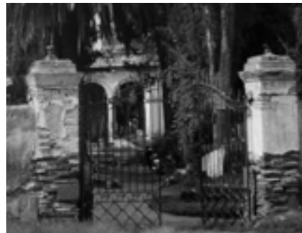
Humedad. Palacete de la Florida – Chuquisaca, Bolivia
