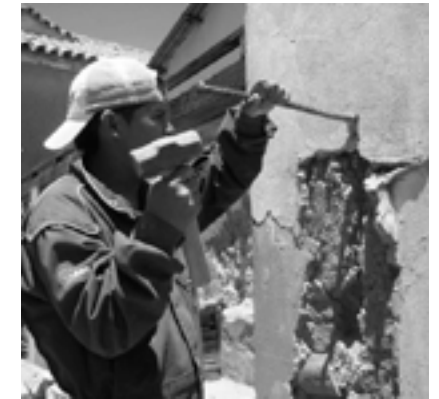
Retiro de revoque de cemento. Convento de Santa Teresa – Sucre – Chuquisaca, Bolivia
