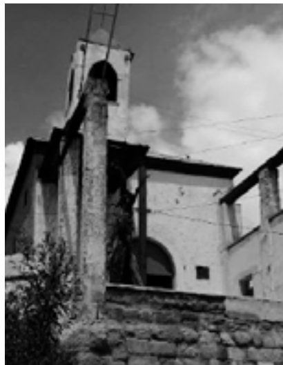
Las torres, las columnas y las vigas son elementos añadidos. Templo de San José - Oruro, Bolivia
