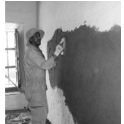
Restitución de revoque de cal y arena. Celda del Claustro del Convento de Santa Teresa – Sucre – Chuquisaca, Bolivia
