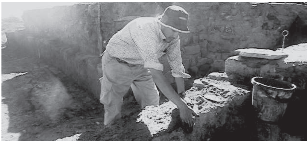
Foto 4. Trabajos de consolidación de muros - Fuerte de Samaipata
