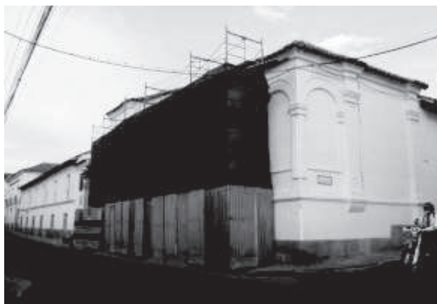
Instalación de faenas y armado de andamios. Obra: Restauración, refuncionalización - Museo Colonial Charcas (Sucre)
