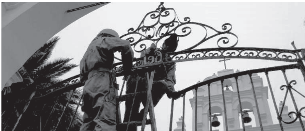
Obra: Restauración de la reja principal Iglesia de San Lázaro (Sucre)
